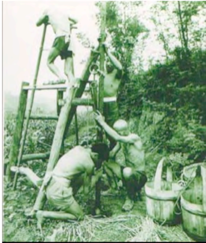
Fig. 7. Samtida enkel kinesisk Linstötbormaskin (Källa: European Geoscience Union, 2004).
