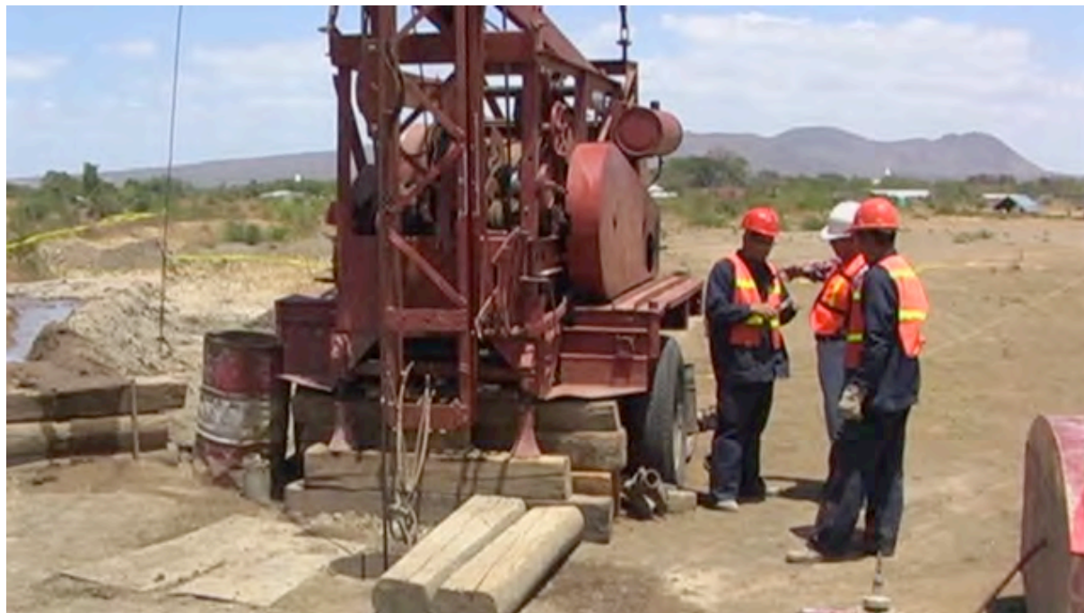
Fig. 8. Modern Linstötmaskin på brunnsborrningsarbete i Nicaragua vintern 2007. Foto förf.
